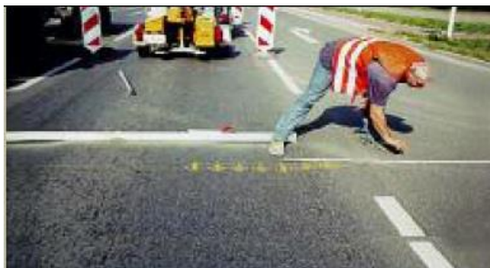
Puurkehade võtmine varem määratud ja teibiga märgitud asukohtadest
