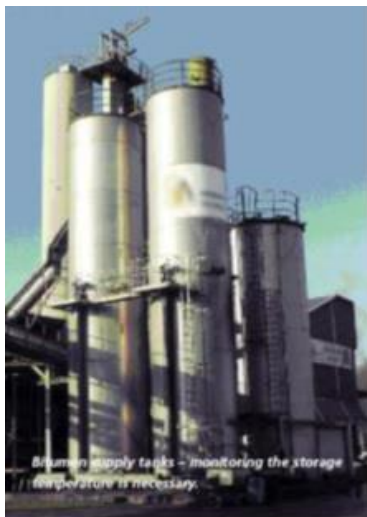
Bituumeni tarnemahutid – ladustamise temperatuuri seire on vajalik
