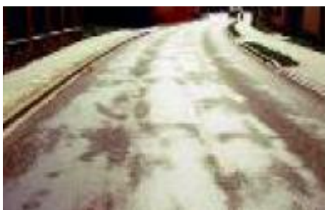
„Higistamine“ (bituumeni tõus pinda) kiudpelletite puuduliku hajutatuse tõttu segus
