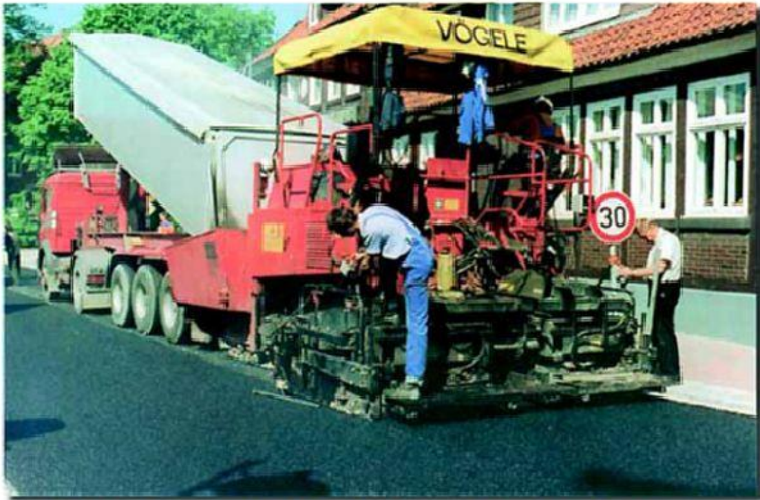
Õhukese killustikmastiasfaldist kulumiskihi laotamine linnatänaval
