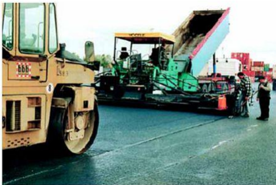
Laoplatsi sillutamine KMA kulumiskihiga
