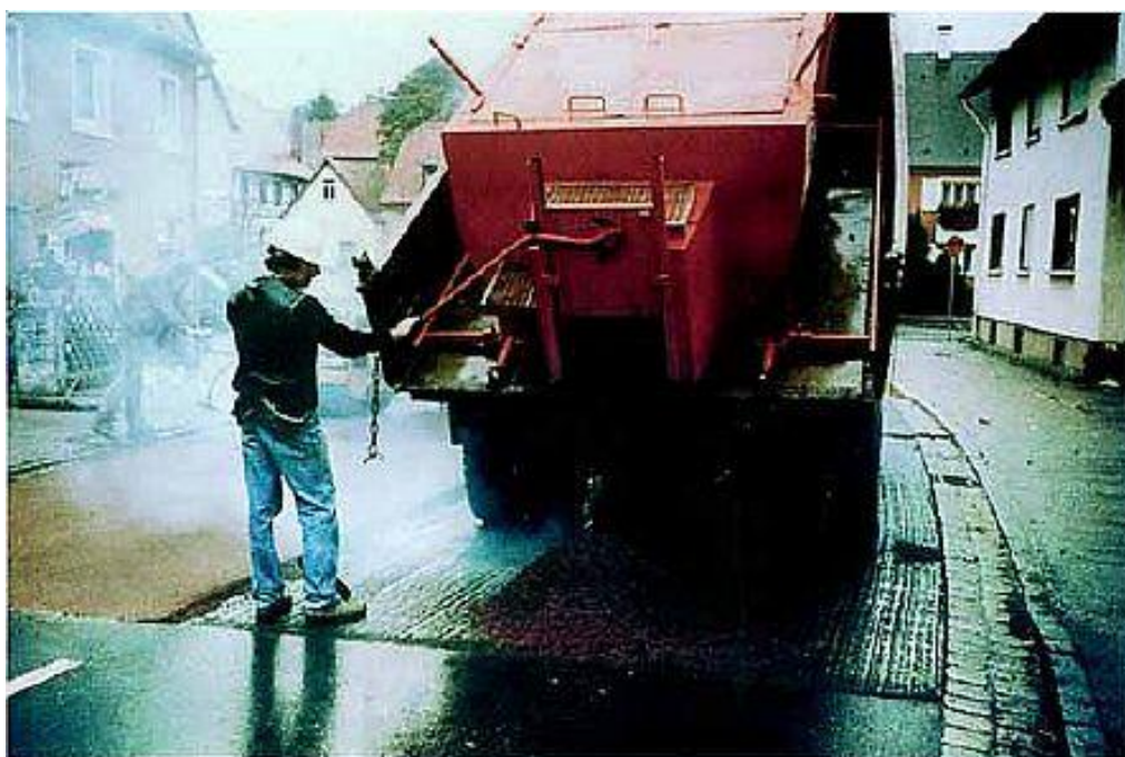
KMA kohaletoimetamine termokonteineris
